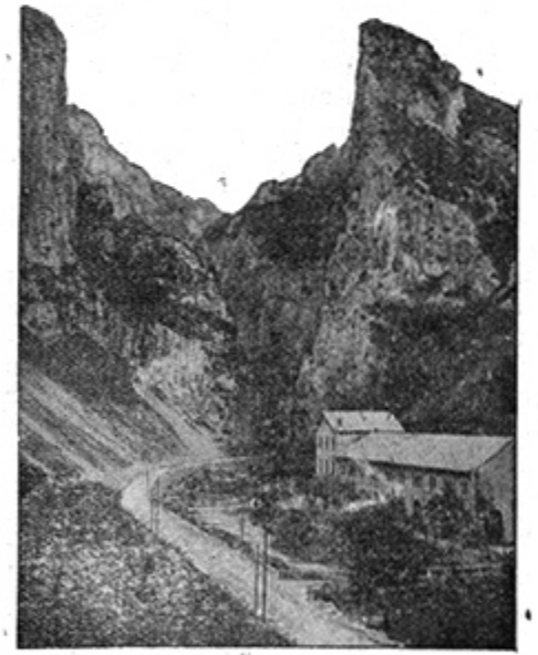
Entrée des Gorges St-Georges. L'Usine Hydro-Electrique.
